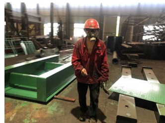
敞开式厂房刷漆、晾漆
